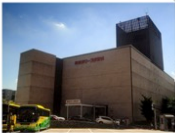
☆正面玄関の様子
