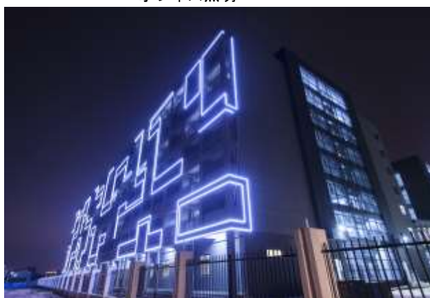
壁面装飾照明
