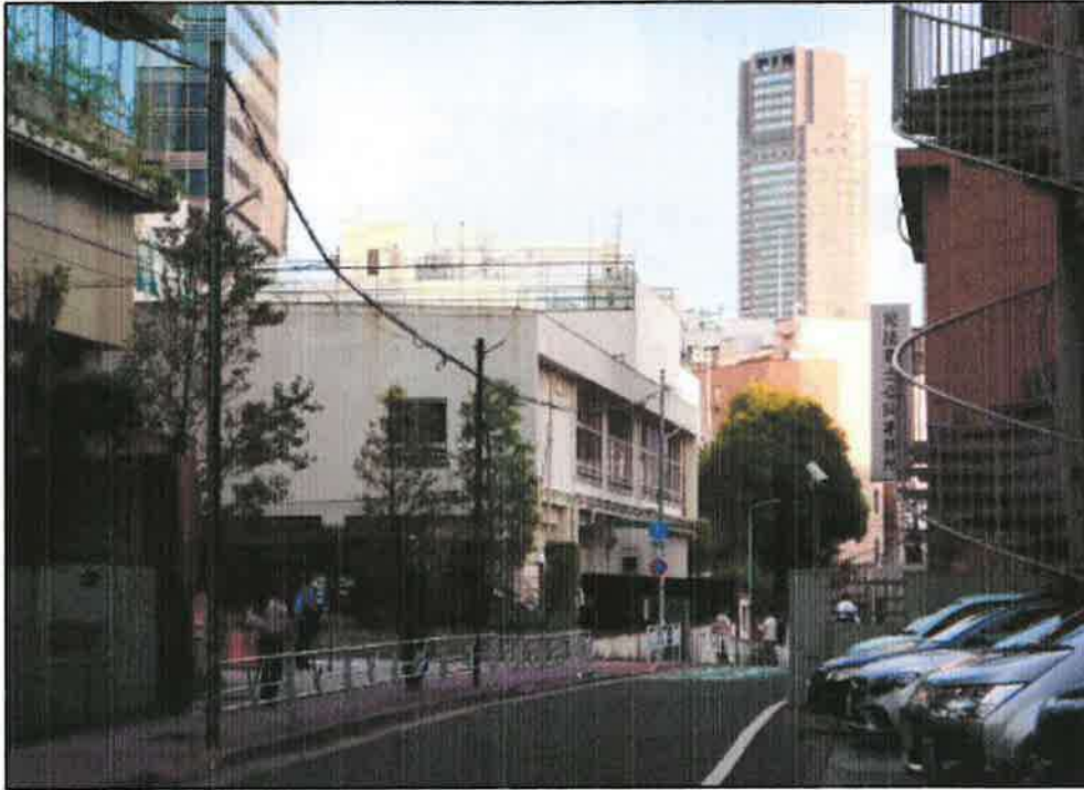
対象不動産全景：北西方より撮影
