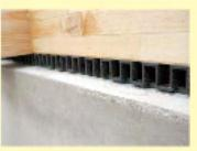
床下換気には、湿気を効率的に排出し、シロアリの繁殖や柱脚部の腐食を防止する「基礎パッキン工法」を採用。これは木造土台部分とコンクリート基礎の間にパッキンを入れて固定するもので、一般的な基礎切り欠き換気口に比べ、1.5~2倍の換気性能を発揮。基礎の強度性能を低下させる心配もありません。
