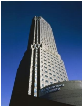
セルリアンタワー東急ホテル
