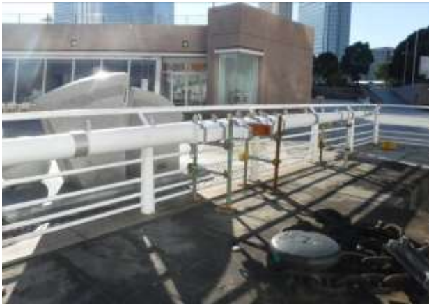
帆船日本丸のヤード 2022(令和4)年 昨年度の船体整備工事で交換されたヤード
