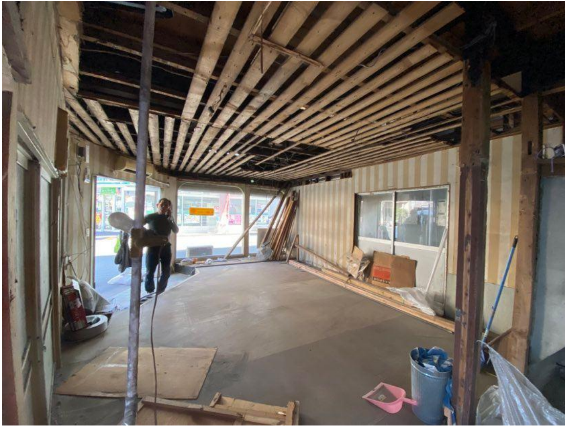
↑1階カフェ部分:解体作業が進み、開放的な空間になってきている途中の様子
