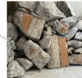
解体時に出たコンクリート破片を石積みしたカウンター台
