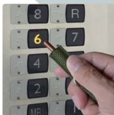
エレベーター
