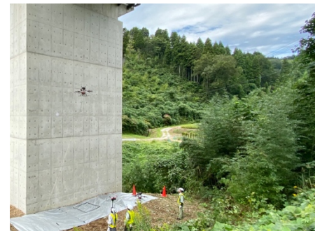
ドローンでの橋梁点検の様子
