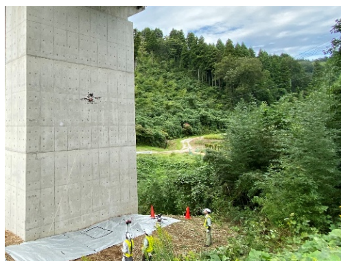
橋梁点検中のマルコ®
