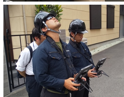
ドローンでの外壁点検の様子
