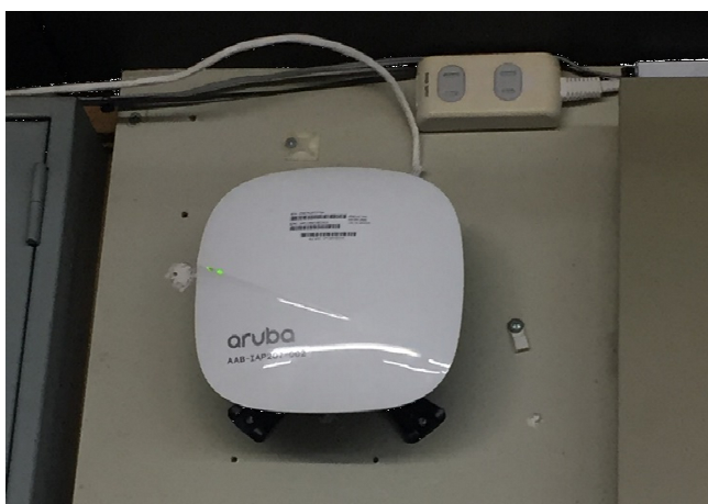
↑機器設置写真
