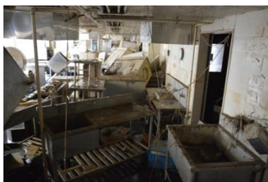
排水作業完了後の地下1階(厨房)
