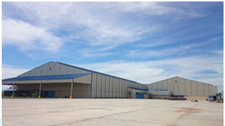
設備写真 (工場全体)
